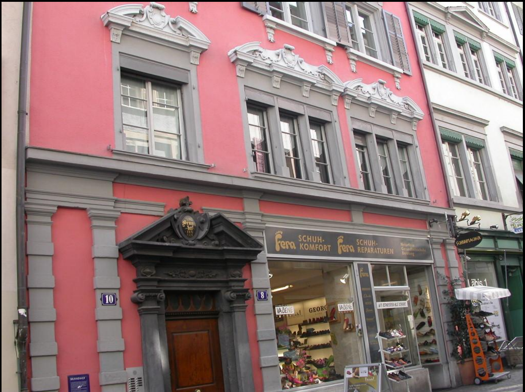
Haus zum „Brunnenhof“, Brunngasse 8
